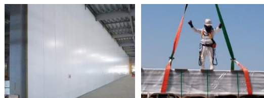
耐火/不燃断熱パネル設置工事
