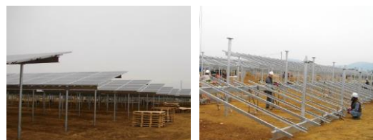
太陽電池アレイ支持架台設置工事
